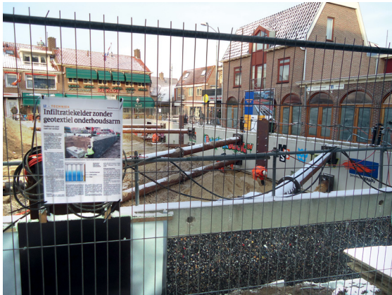
Figuur 4.4 Aanleg infiltratiebassins in het centrum.
